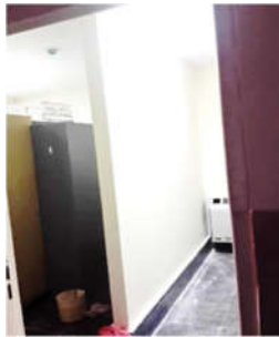
دیوار چینی گچ‌کاری و رنگ‌آمیزی در سلف پردیس
