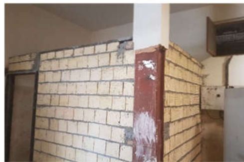
اتاق رختکن پرسنل سلف حین احداث
