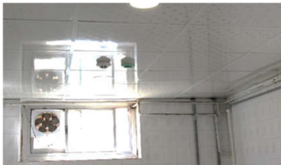
شکل ۱. ۴۵: پروژه تعمیرات مجموعه خوابگاه‌های کوثر (کنترل تجهیزات و نحوه استفاده از آن‌ها)
