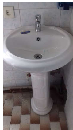
تعویض روشویی‌ها و شیرمخلوط‌های معیوب سرویس‌ها
