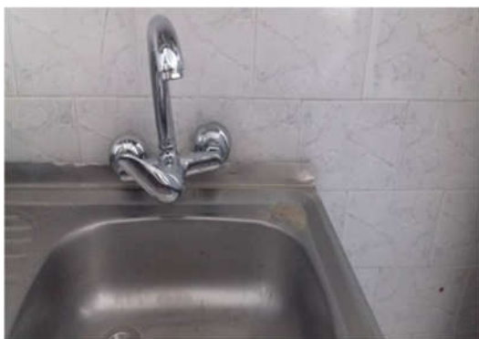
تعویض شیرمخلوط‌های آشپزخانه‌ها
