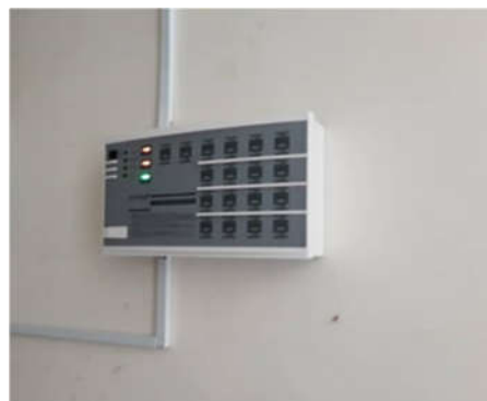
اجرای سیستم اعلام حریق
