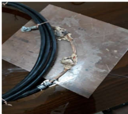
اجرای سیستم ارت
