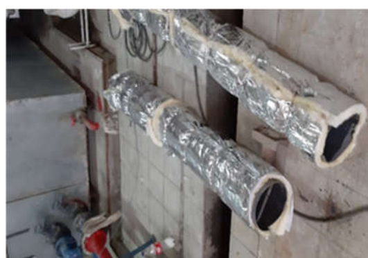
عایق‌کاری و تغییر لوله دودکش‌ها به لوله‌های فلزی
