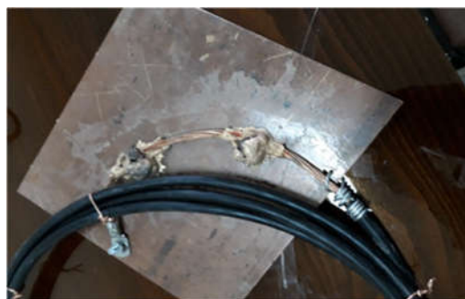
اجرای سیستم ارت جهت سرورهای IT
