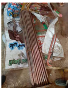
اسیدشویی کویل منابع آب گرم
