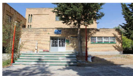
تعویض درب ورودی بلوک ۴
