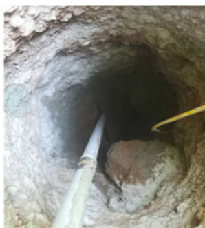
اجرای چاه ارت
