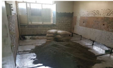
کاشی و سرامیک بدنه و کف حین کار
