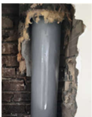
تعویض لوله دودکش‌ها
