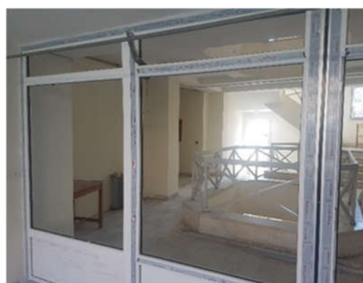
نصب پنجره‌های دوجداره
