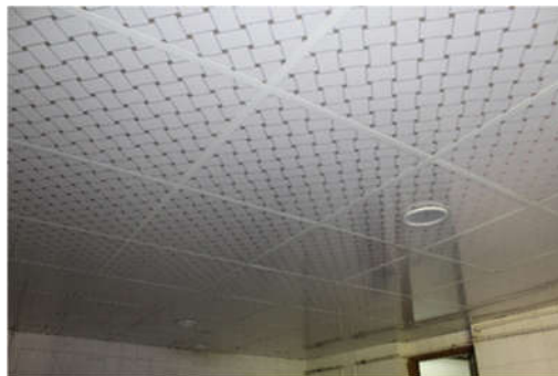
تعویض سقف کاذب سرویس بهداشتی، حمام و آشپزخانه‌ها
