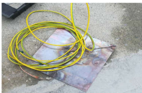
اجرای سیستم ارتینگ جهت رک بلوک گیت‌ها
