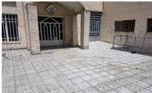
اجرای موزاییک محوطه ورودی سلف
