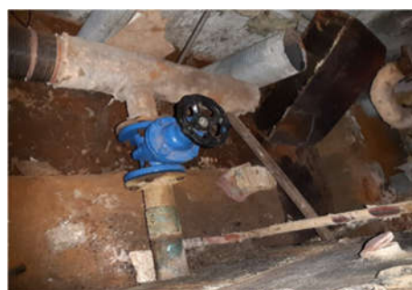
اصلاح لوله خروجی دیگ موتورخانه
