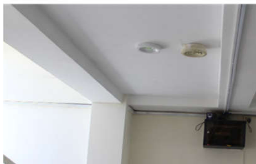
شکل ۱. ۴۳: پروژه تعمیرات مجموعه خوابگاه‌های کوثر (کنترل سیستم روشنایی و برق مصرفی)
