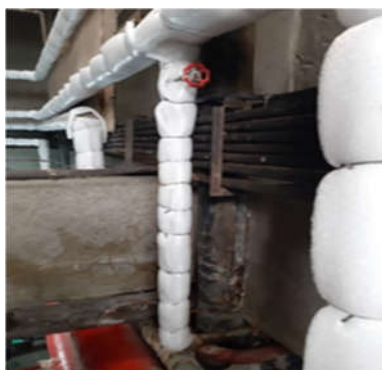
عایق‌پیچی لوله‌های آب موتورخانه
