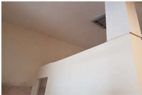
احداث اتاق رختکن پرسنل سلف
