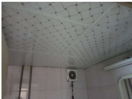
برچیدن دامپا و نصب سقف کاذب PVC
