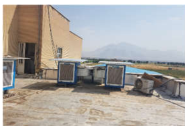
نصب سایه‌بان کولرهای ساختمان شماره ۲
