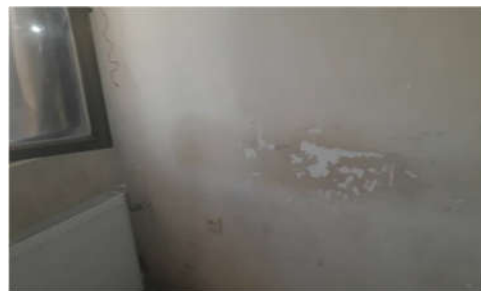
دیوار اتاق ها قبل از رنگ آمیزی
