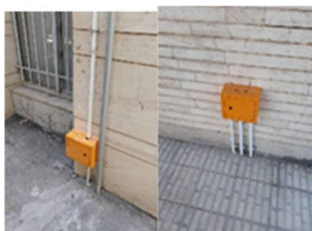
نصب جعبه تست ارت
