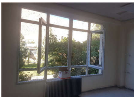
نصب پنجره‌های دوجداره
