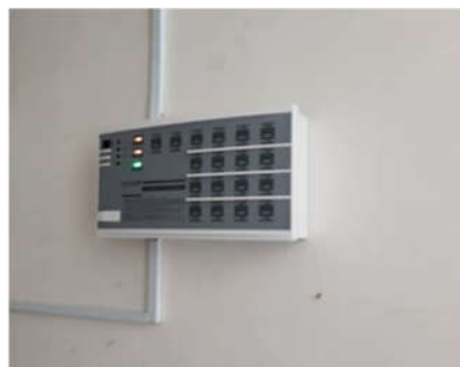
نصب سیستم اعلام حریق
