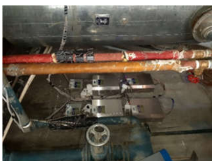
نصب سختی گیر الکترونیکی
