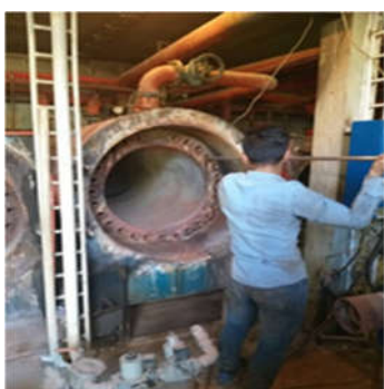
تعمیر و سرویس دیگ‌ها
