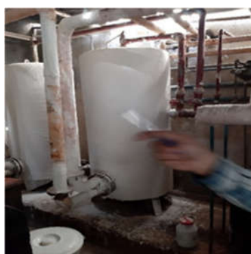
عایق‌پیچی منابع آب مصرفی و رفع نشتی
