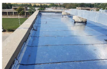
عایق‌کاری رطوبتی سقف سلف کشاورزی
