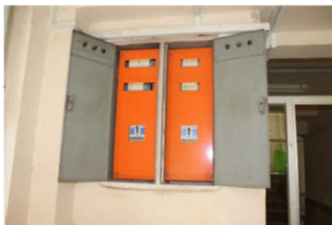
بازسازی و اصلاح تابلو برق‌ها
