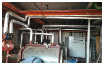
عایق کاری موتورخانه
